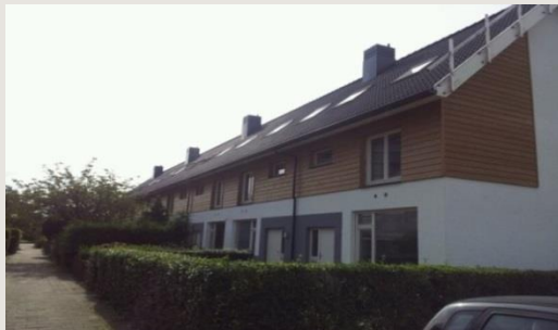
Project schilrenovatie te Hoek van Holland i.o.v Willems Vastgoed Onderhoud
